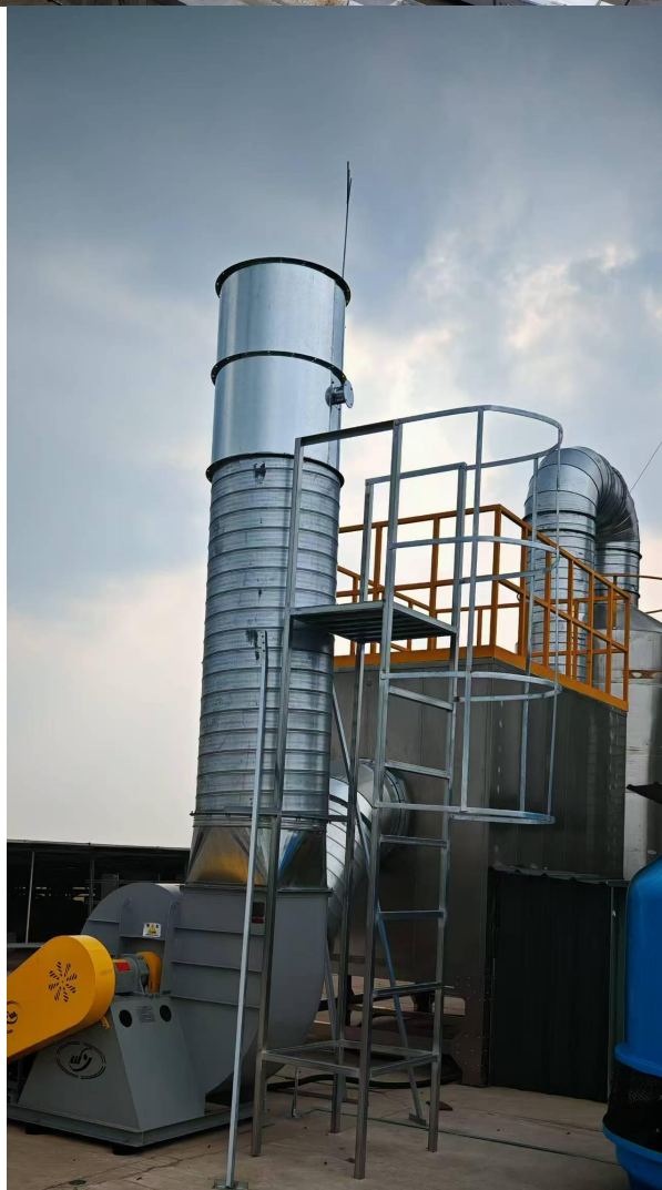
DA001 废气排放口（水喷淋吸收+除湿+活性炭吸附，40 米/2 号厂房）
