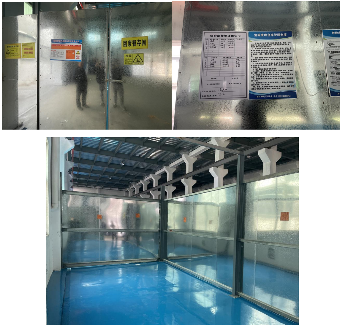
危废暂存间照片
